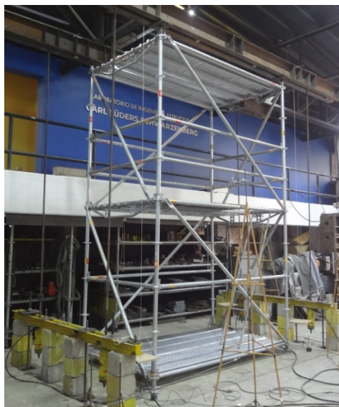
Figura 7.9.2 Montaje del ensayo
