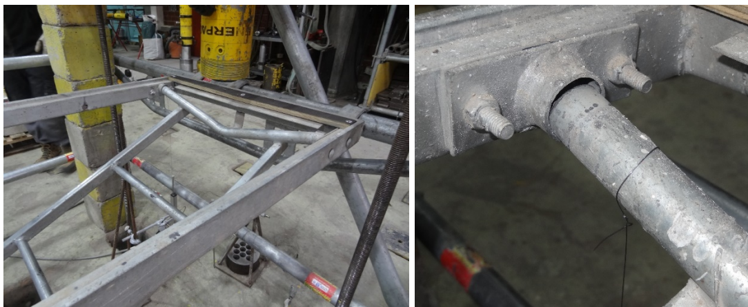
Figura 7.12.6 Estado final probeta ECE-ESCALERA-01
