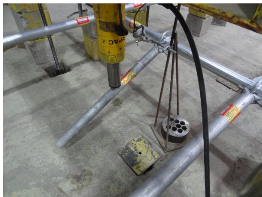
Figura 7.16.5 Estado final probeta EFT-CONEXIÓN-01
