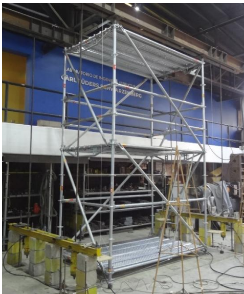
Figura 7.9.2 Montaje del ensayo
