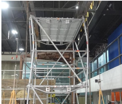
Figura 7.9.6 Estado Final Probeta ERT-TORRE-01
