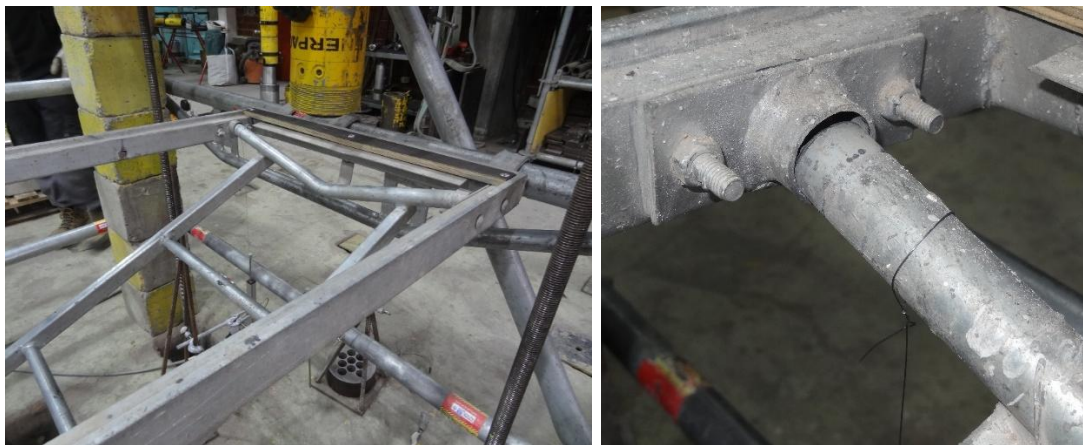
Figura 7.12.6 Estado final probeta ECE-ESCALERA-01
